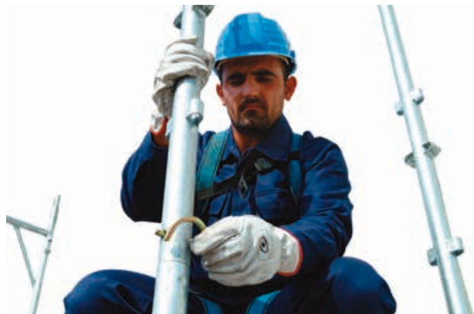
29 • montaż kołków ramy
