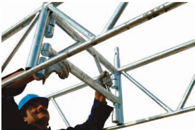
67 • montaż belek łącznikowych wiazara przejazdowego
