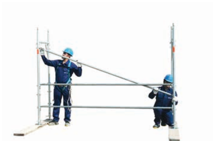
7 • montaż stężenia poziomego
