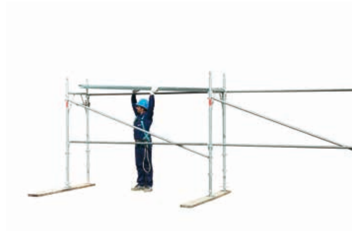
16 • montaż płyt stalowych
