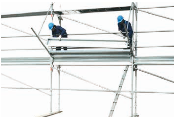
57 • montaż desek do osłony odpryskowej
