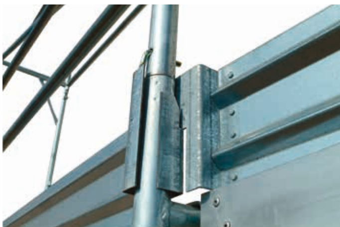
38 • detal bortnicy na poziomie 1
