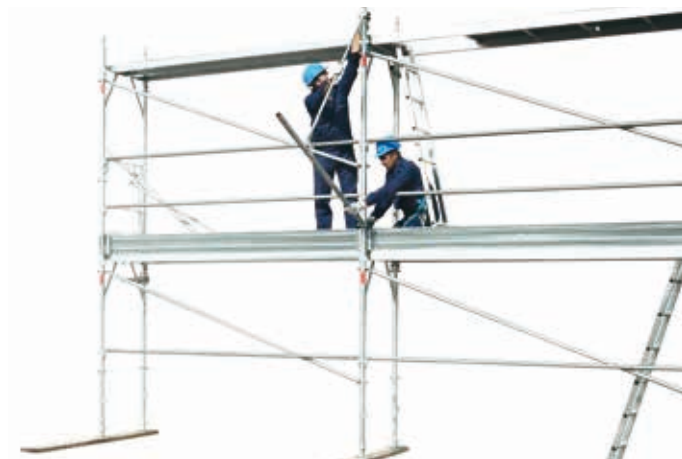
53 • montaż wspornika osłony odpryskowej
