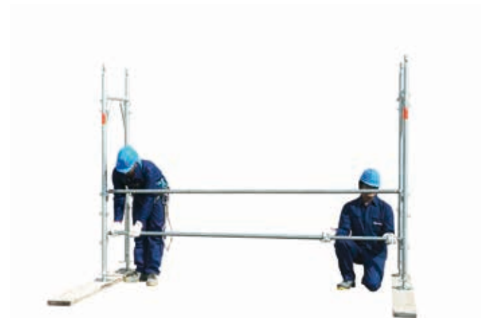
6 • montaż drugiej poręczy
