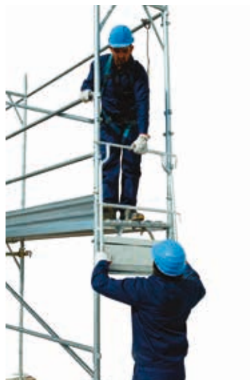
40 • montaż balustrady czołowej na poziomie 1
