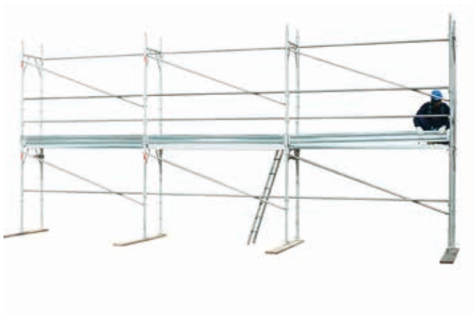
39 • montaż bortnicy na poziomie 1
