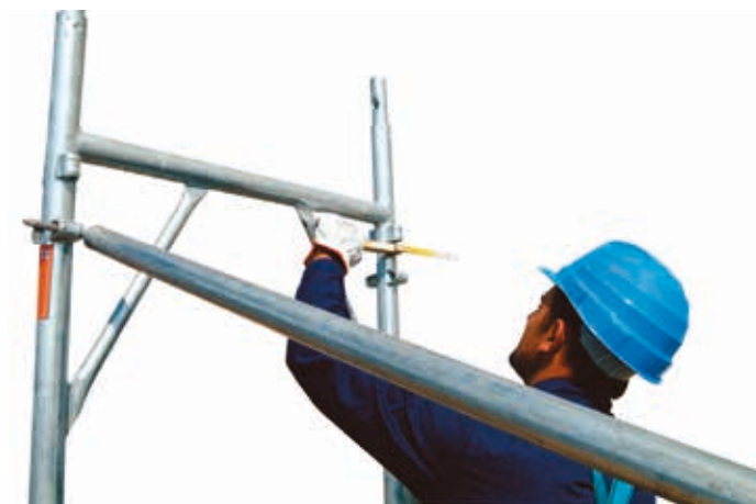
9 • sprawdzenie odległości od elewacji
