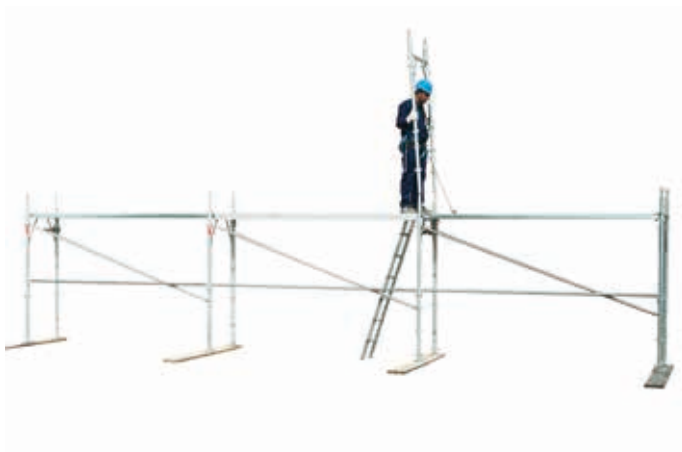
27 • montaż ramy na poziomie 1
