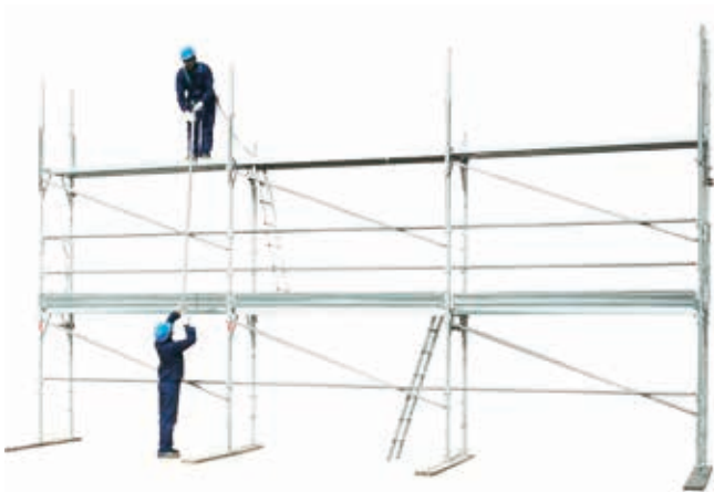
51 • montaż poręczy i valustrad na poziomie 2
