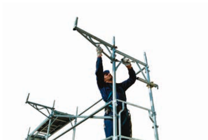
59 • montaż wspornika i stężenia wspornika
