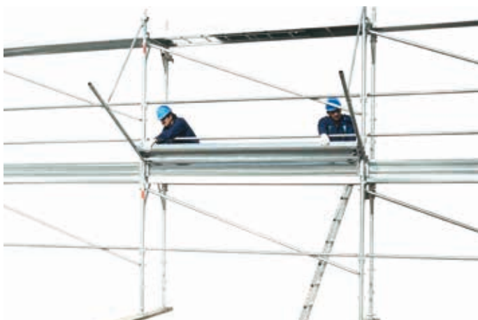
56 • montaż desek do osłony odpryskowej
