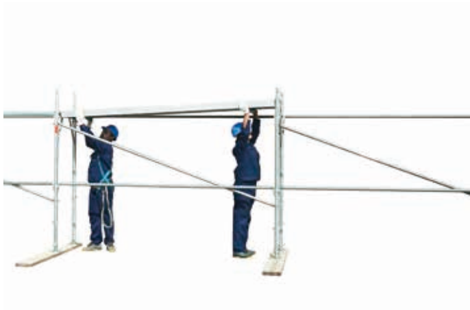
19 • montaż płyty z włazem
