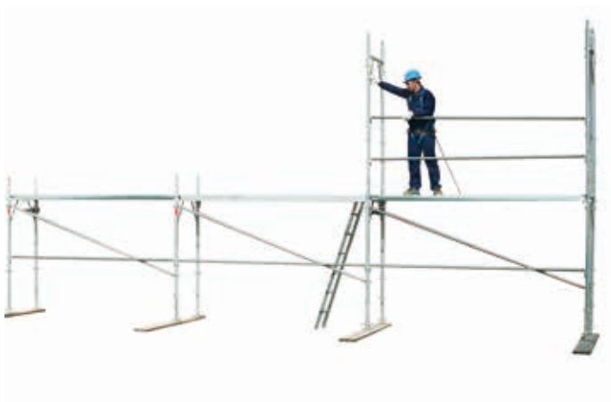
32 • montaż balustrady na poziomie 1
