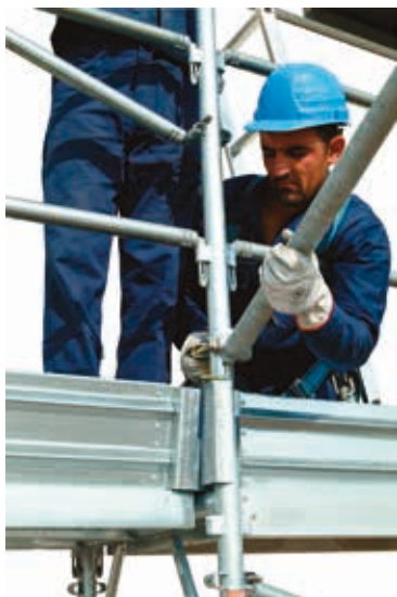
55 • detal wspornika osłony odpryskowej
