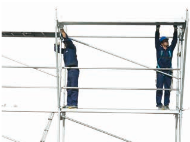
62 • montaż desek na wsporniku
