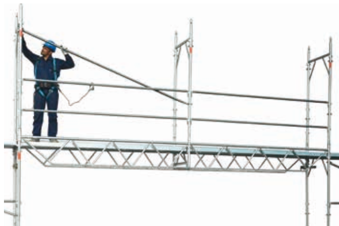
70 • montaż stężeń poziomych nad wiazarami przejazdowymi
