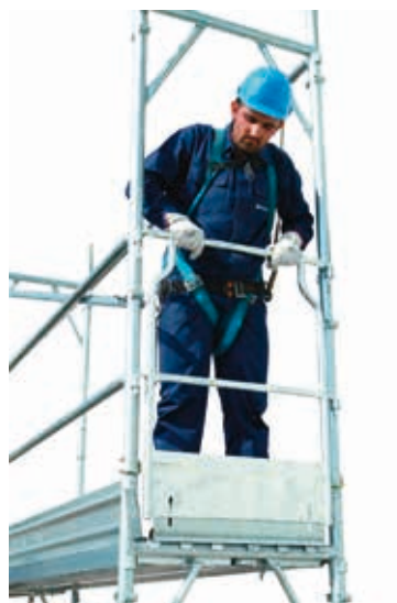
41 • montaż balustrady czołowej na poziomie 1
