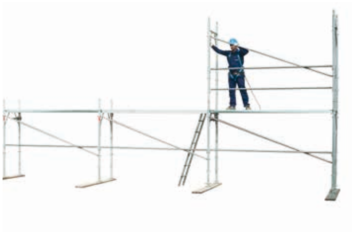
33 • montaż stężenia poziomego na poziomie 1
