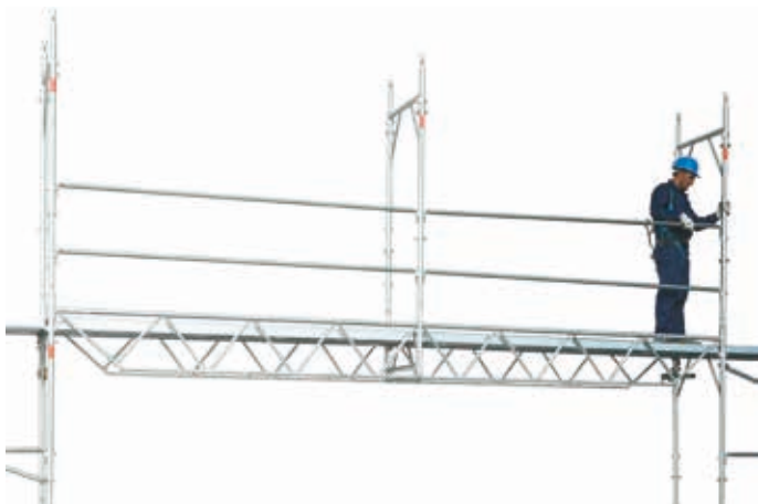
69 • montaż ram i poręczy nad wiazarami przejazdowymi
