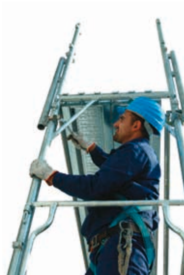
49 • zaciskanie złącza stojaka krańcowego na poziomie 2
