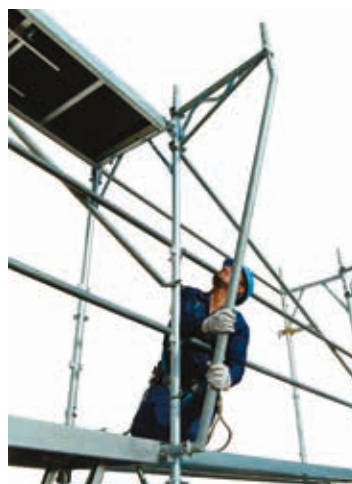
60 • montaż stężenia wspornika
