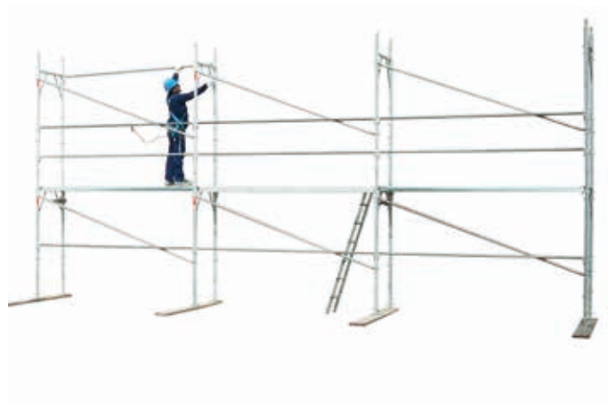
35 • montaż poręczy tylnej na poziomie 1
