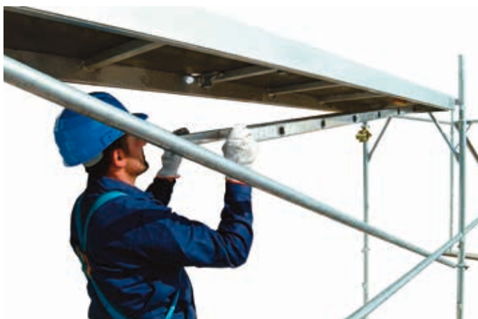
21 • wsunięcie drabinka płyty z włazem
