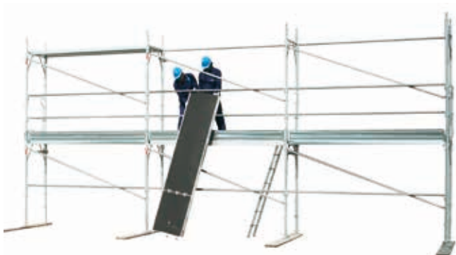
45 • montaż desek z włazem na poziomie 2
