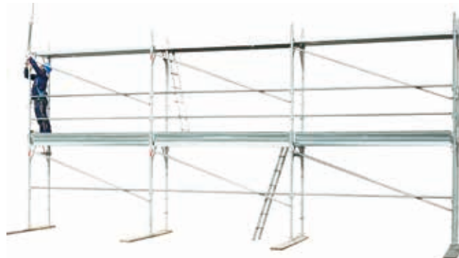
48 • montaż stojaka krańcowego na poziomie 2
