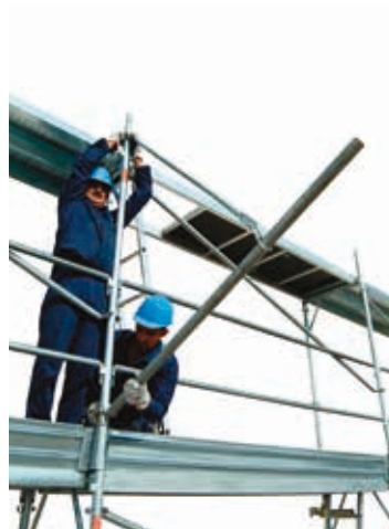
54 • detal wspornika osłony odpryskowej
