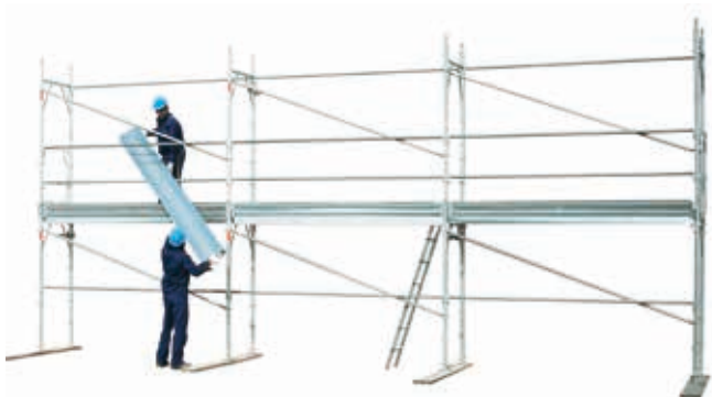
43 • montaż płyt na poziomie 2
