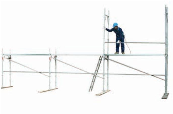
31 • montaż poręczy na poziomie 1
