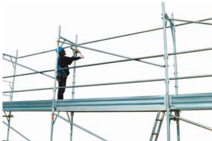
42 • montaż kotwienia na poziomie 1 o ile wymagane
