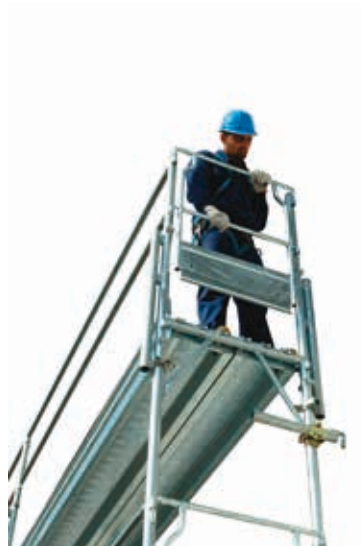
52 • montaż balustrady czołowej na poziomie 2
