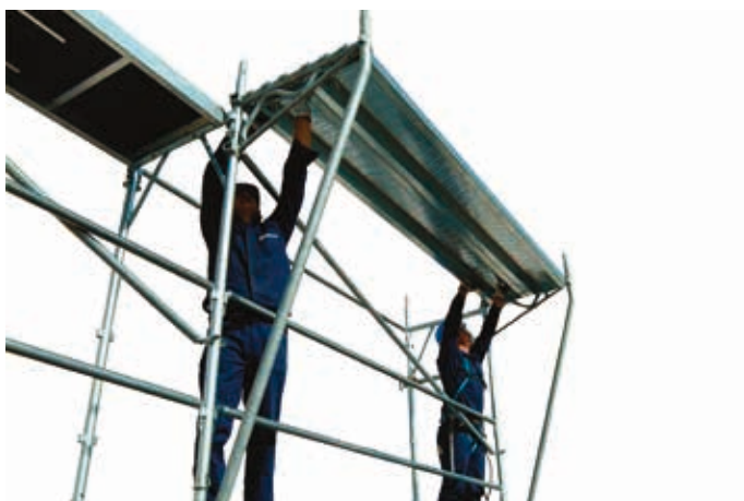
63 • montaż desek na wsporniku
