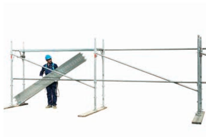
17 • montaż płyt stalowych
