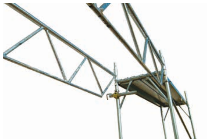
66 • montaż wiązara przejazdowego
