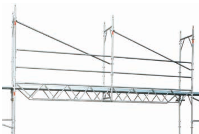
71 • koniec montażu nad wiazarami przejazdowymi
