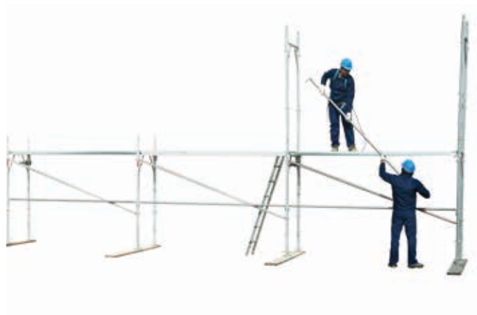
30 • montaż poręczy na poziomie 1
