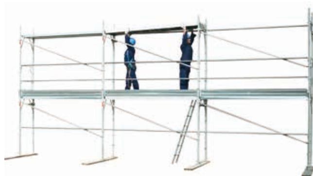
46 • montaż desek z włazem na poziomie 2
