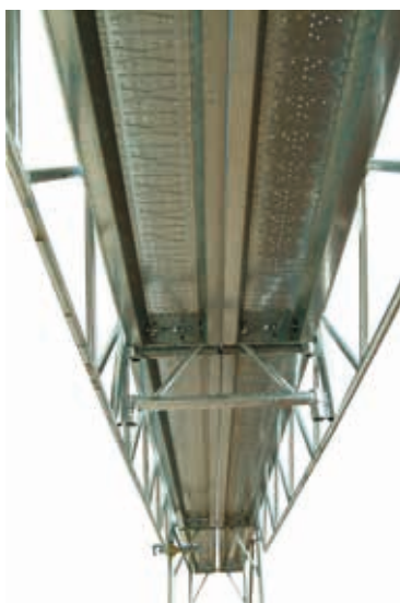
68 • montaż podestu na wiazarach na d przejazdem
