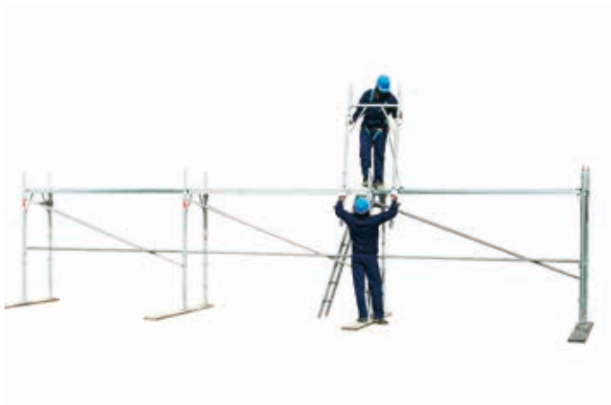
26 • początek montażu ram na poziomie 1
