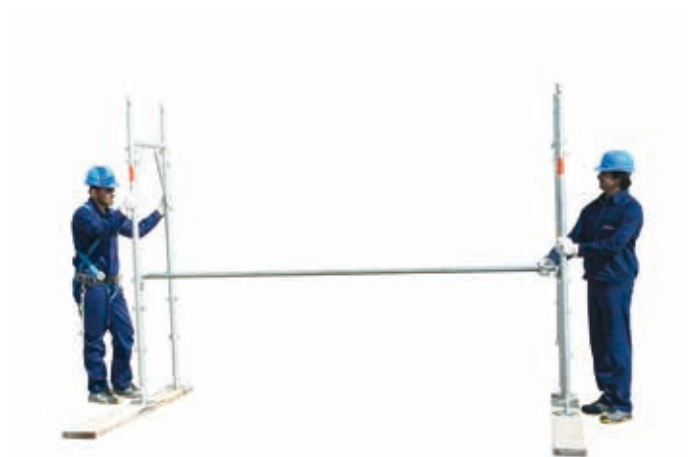
5 • montaż drugiej ramy wraz z balustradą
