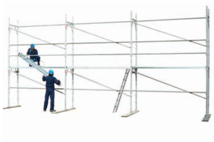
36 • montaż bortnicy na poziomie 1
