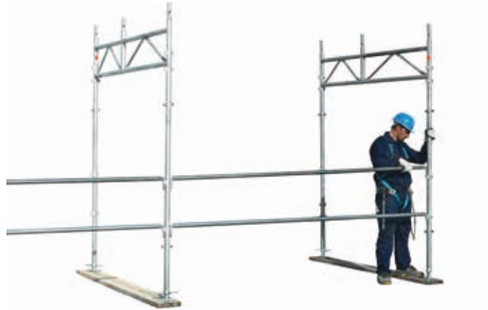
64 • montaż połączeń ramy nadchodnikowej
